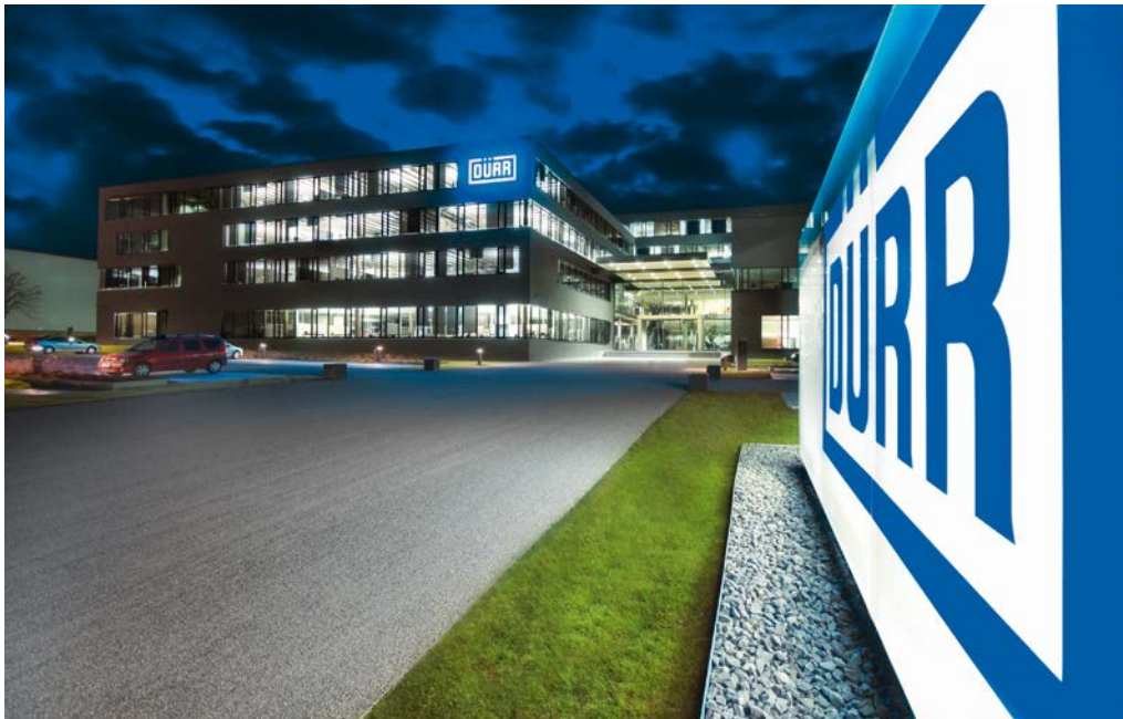
Der Dürr-Campus in Bietigheim-Bissingen mit seiner nachhaltigen Bauweise und Energieversorgung ist unser Vorzeigestandort.
