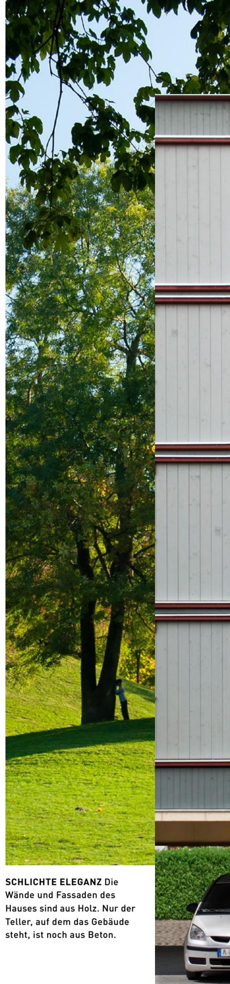
**SCHLICHTE ELEGANZ** Die Wände und Fassaden des Hauses sind aus Holz. Nur der Teller, auf dem das Gebäude steht, ist noch aus Beton.
