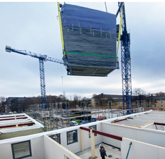
Im Holzfertigbau heben Kräne vorgefertigte Komponenten in Minuten an ihren Platz. Selbst komplette Badezimmer lassen sich so ins Gebäude einsetzen.
