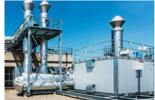
Ist die Abluftreinigungsanlage **Oxi.X RV** einmal auf Betriebstemperatur, läuft sie energetisch gesehen von selbst.
